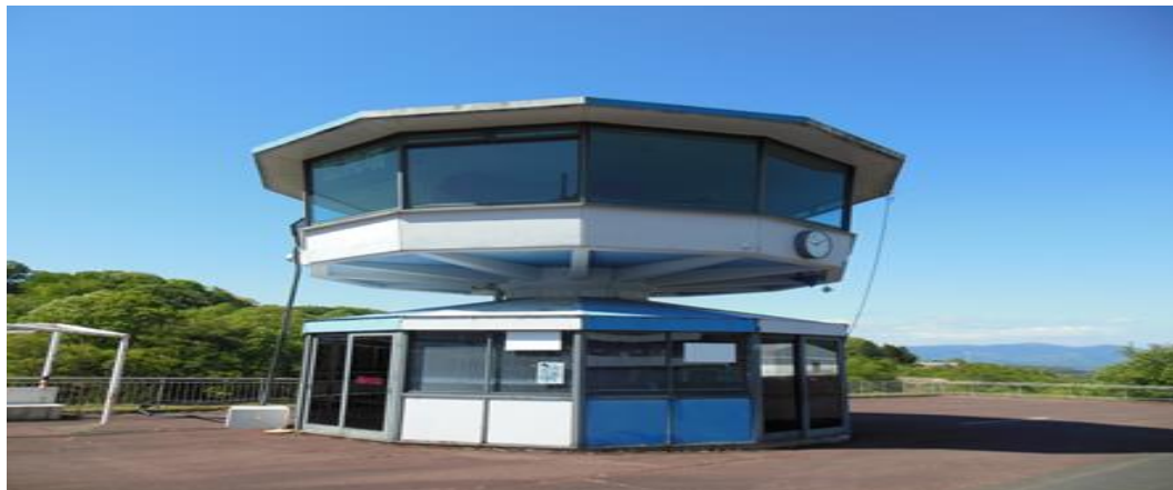
5キロサーキット監視塔
